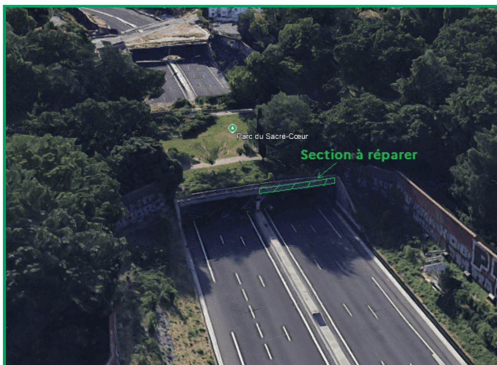
Figure 4 : Localisation de l'ouvrage et des éléments à réparer
